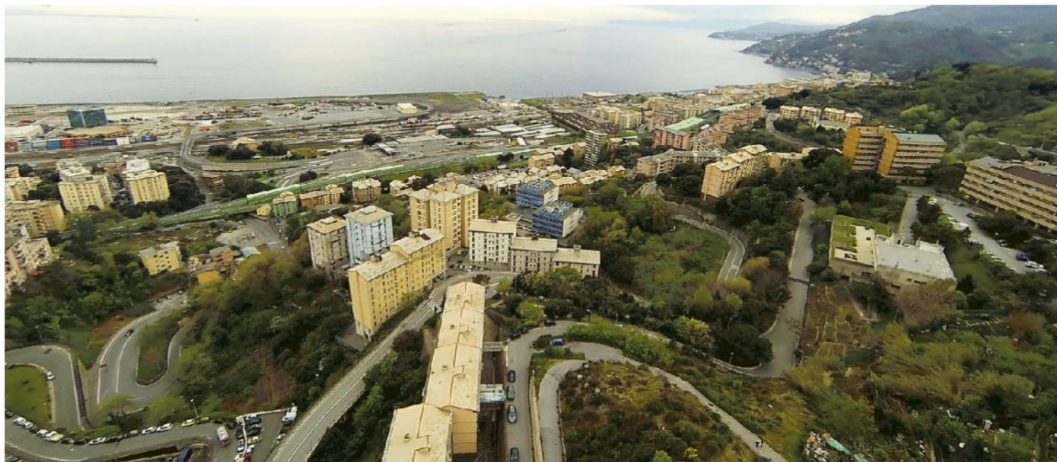
Una veduta dall'alto del quartiere del Cep
